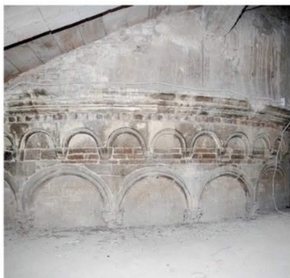
Veduta del paramento in arenaria con zooforo di età romanica nel sottotetto addossato a nord-est della muratura laterale del presbiterio.
