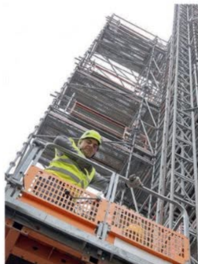
Il montacarichi sul lato nord per accedere a tetto e sottotetto.
