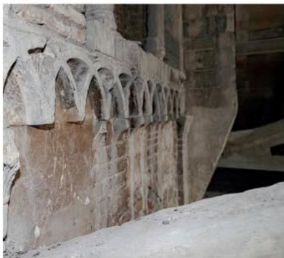
Paramento in laterizio e arenaria di età romanica nel sottotetto addossato a sud-est della muratura laterale del presbiterio.
