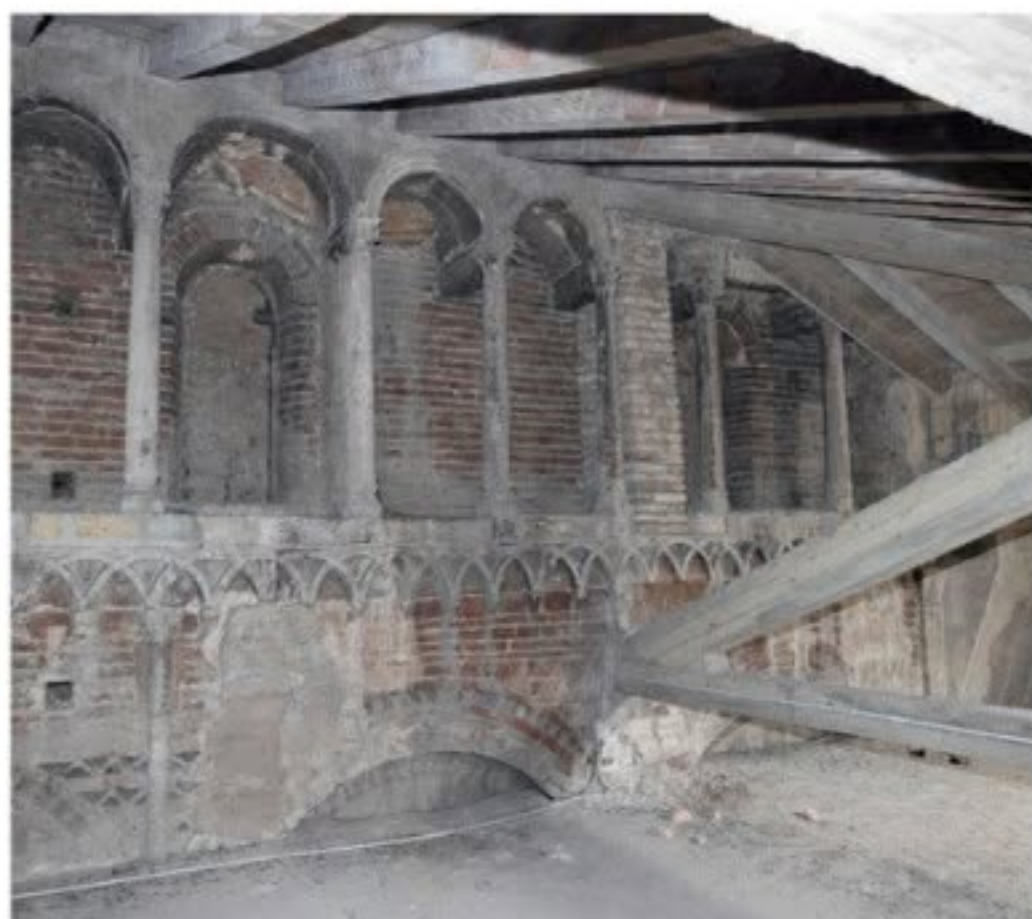
Veduta delle carpenterie metalliche di consolidamento della struttura portante in ca di copertura della navata centrale della cattedrale.
